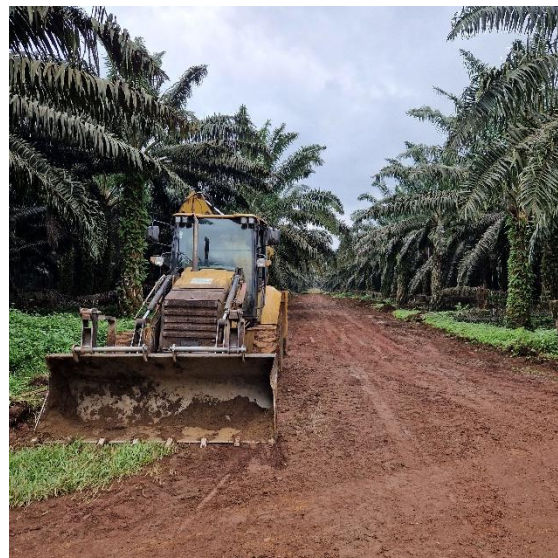
Figura8 : Manutenção de estradas
