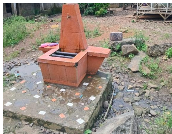
Figura20 : Reparação do poço de água em Monte Mario
