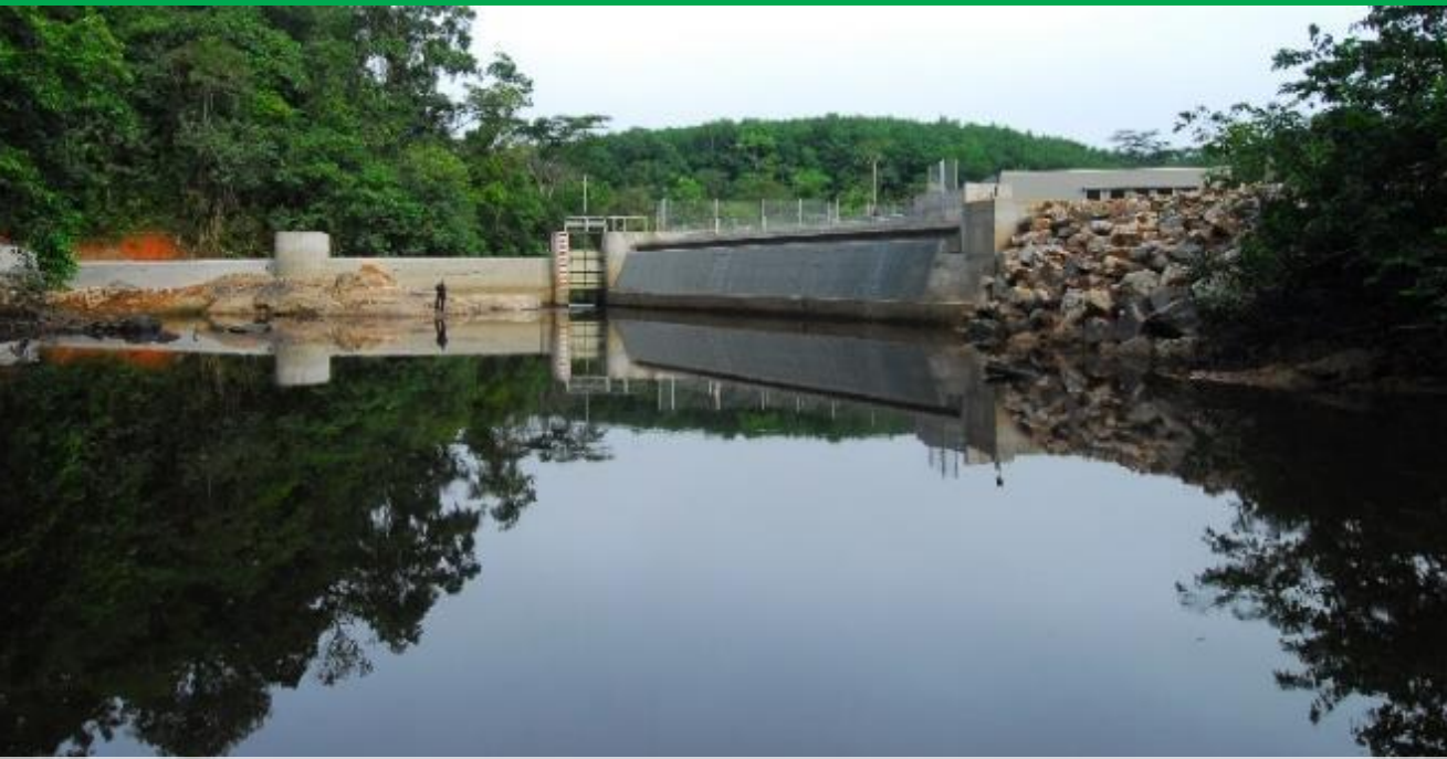
Construction d'un barrage hydroélectrique au Libéria (2016)
