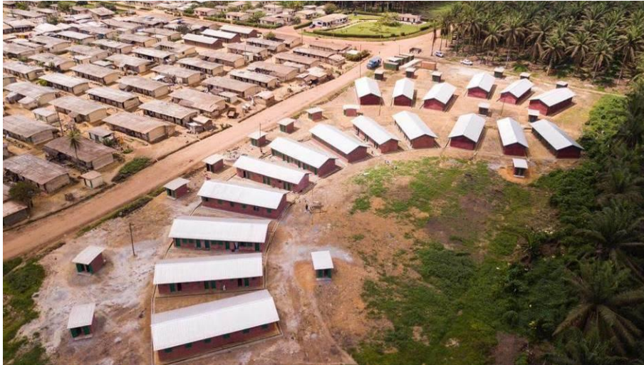
Rénovation du Village 1, site de Kienké
