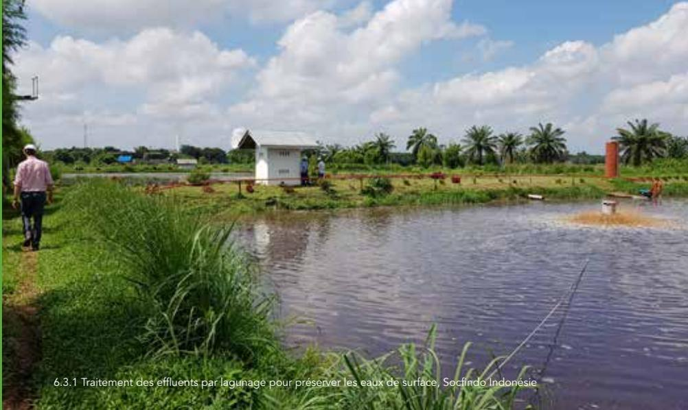
6.3.1 Traitement des effluents par lagunage pour préserver les eaux de surface, Socfindo Indonésie
