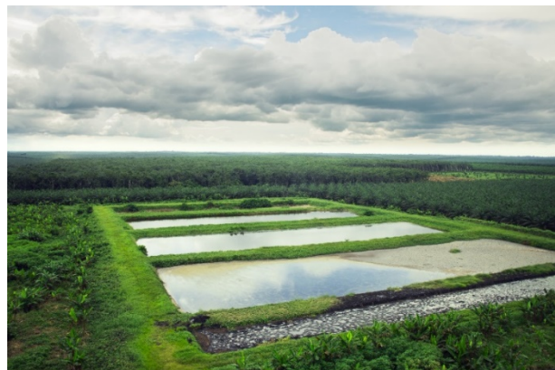
Image 16 : Système de purification de l'eau
